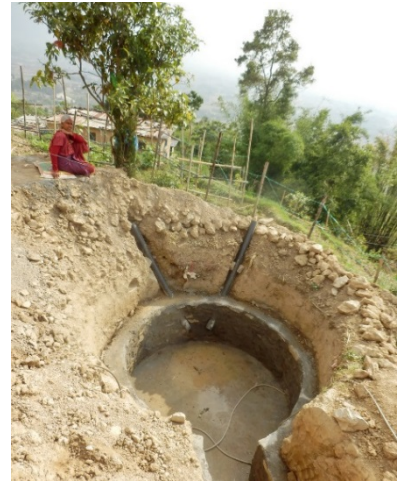
Aufbau einer Biogasanlage | © atmosfair
